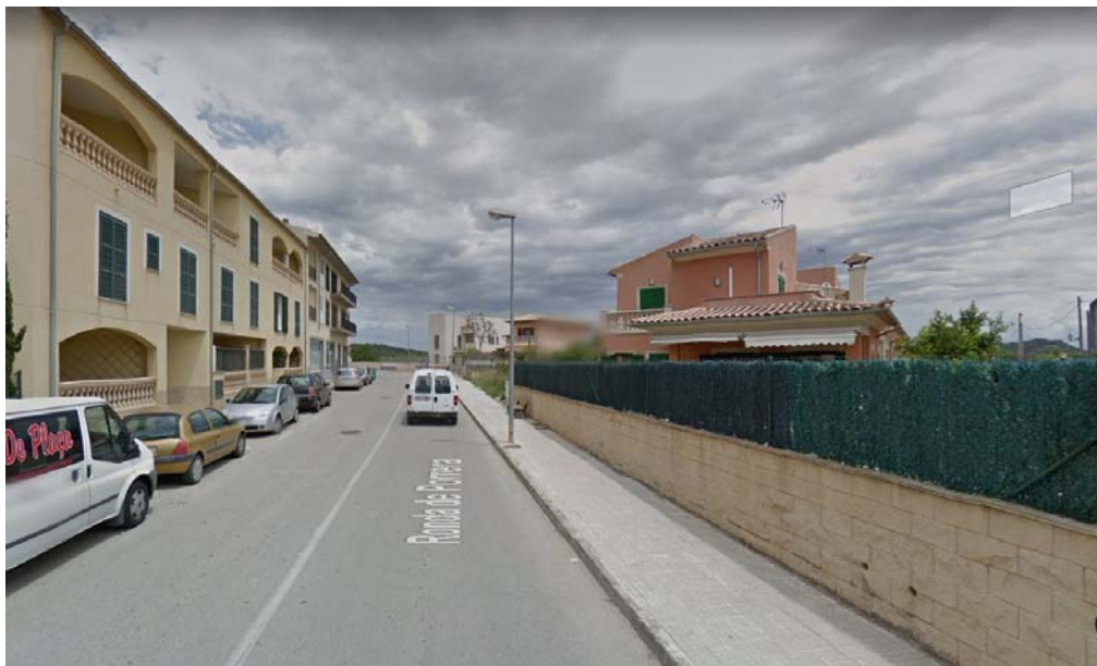
Imatge del tram de la ronda de Porreres la UA-1, amb serveis executats i edificacions construïdes. Font: Google Maps
