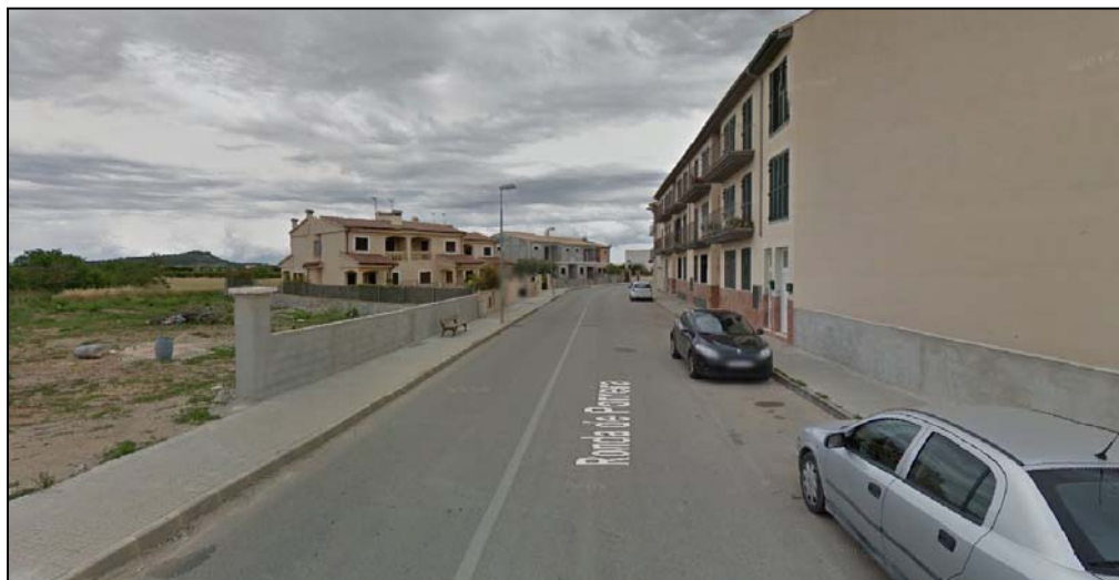
Imatge del tram de Ronda de la UA-3, amb serveis executats i edificacions construïdes. Font: Google Maps
