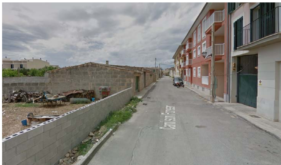
Imatge del tram del carrer des Fonear la UA-2, amb serveis executats i edificacions construïdes. Font: Google Maps
