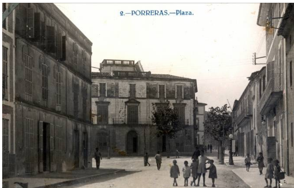
A l'esquerra s'observa l'antiga façana sense balcons
